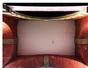
図 2-22 天井応急処置_北脇玄関
