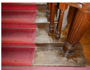
図 2-16 カーペット敷と階段踏面_主階段室
